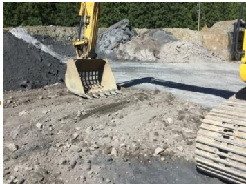
本社内の水溜りのある場所で、RBを直接路盤材として転圧し、地盤を強化した。
