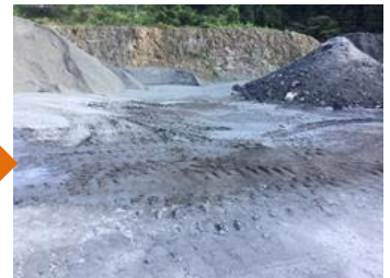
3日後の現場で地盤が強化された
