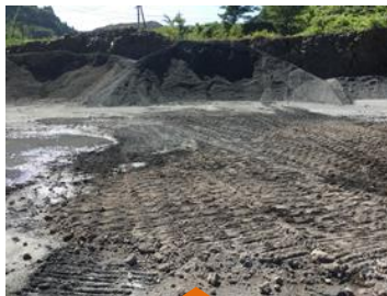
整地して転圧した。
